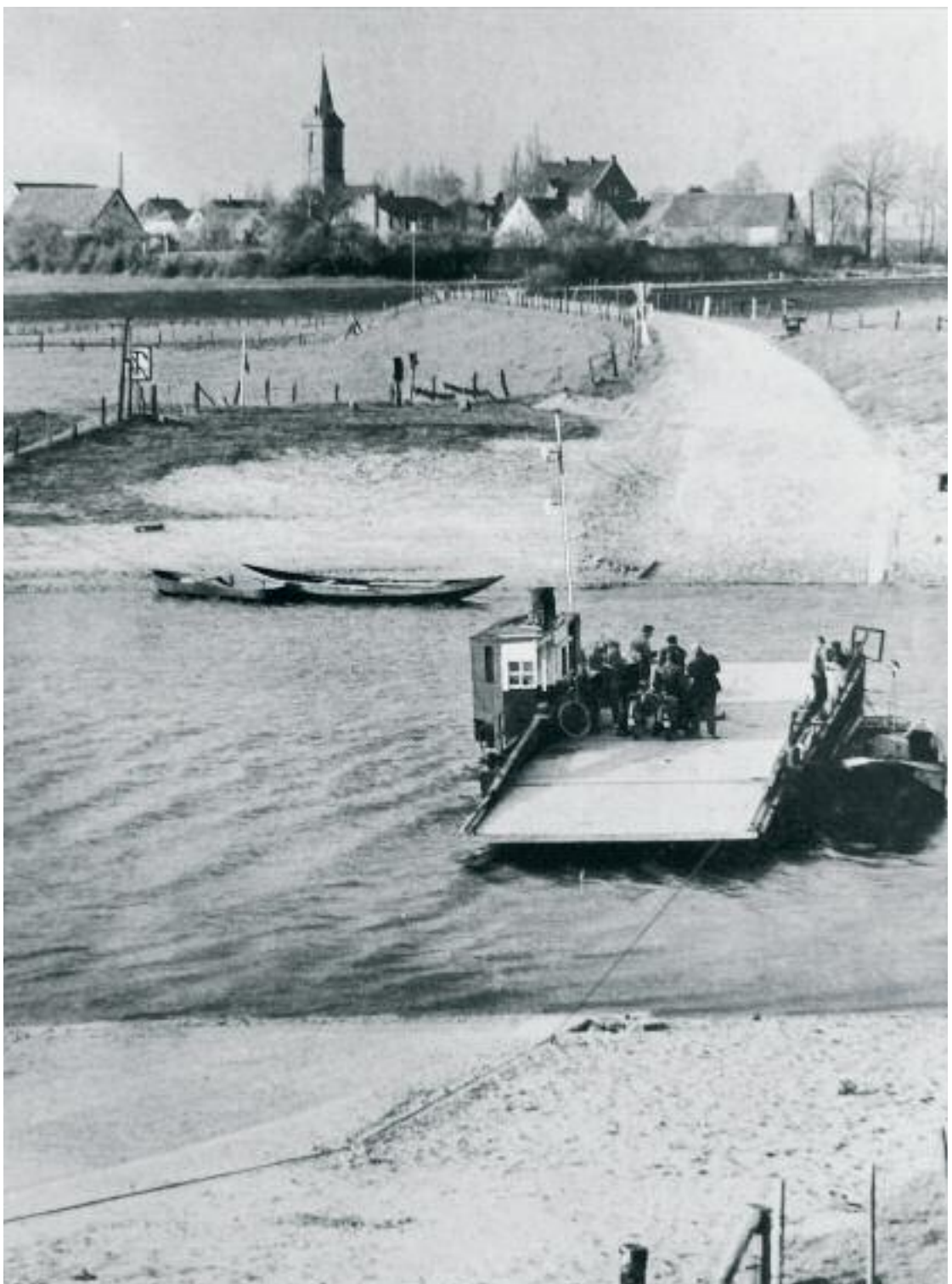
Die zweite Seilzugfähre, vom angebundenen Motorboot gezogen, auf der Überfahrt. Zwei Ruderboote liegen für den Verkehr außerhalb der Fährzeiten am Anleger.
